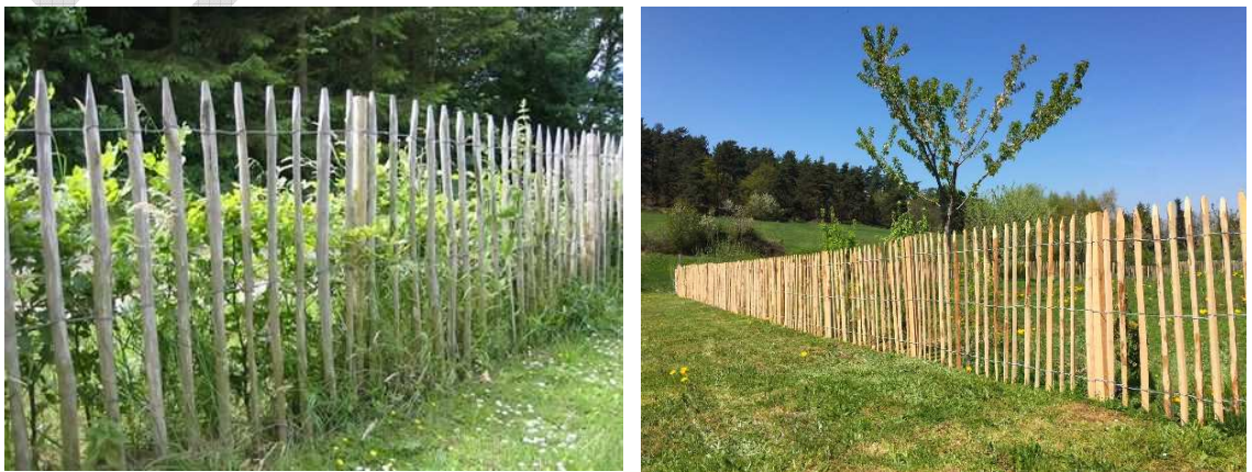
Ganivelle en bois (robinier ou châtaignier). Hauteur maximale = 1.50m. Autorisée en limite latérale et de fond de parcelle sauf celles donnant sur le domaine public (lisière par exemple).
