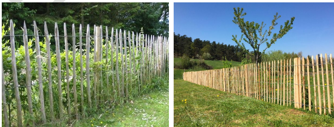
Ganivelle en bois (robinier ou châtaignier). Hauteur maximale = 1.50m. Autorisée en limite latérale et de fond de parcelle
