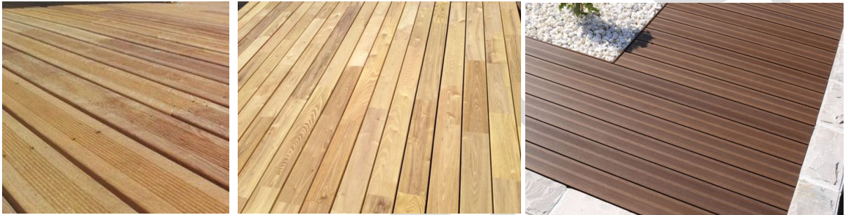
Platelage bois (pin traité, chênes ou faux robinier) ou composite couleur clair/ pas de bois exotique
