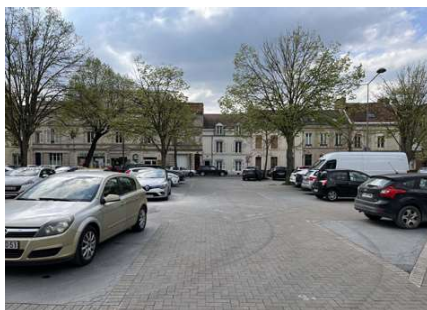
Des allées en pavé béton, et des places en enrobé noir.
