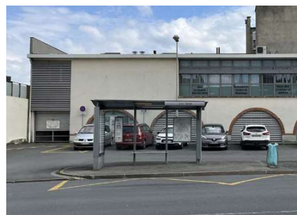
L'arrêt de bus « Luton » Rue de Neufchâtel
