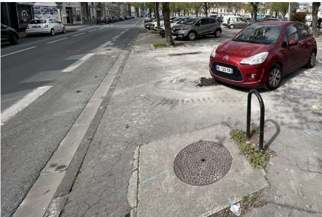
Enrobé dégradé (fissuration, trous...)
