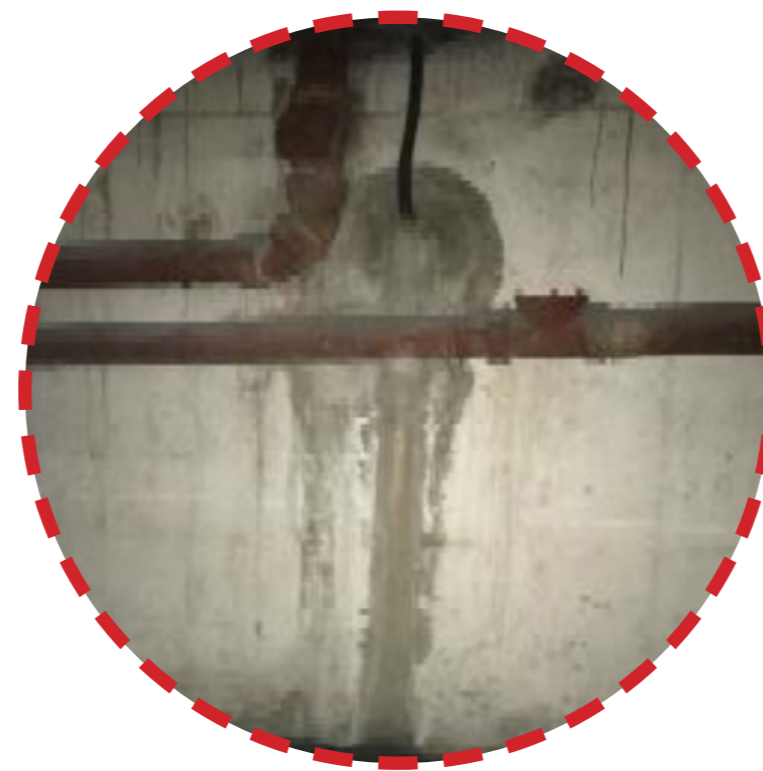
DÉFAUTS D'ÉTANCHÉITÉ
